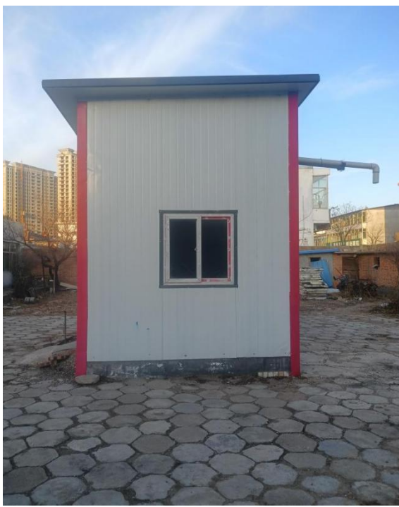
城西后备水源地取水井
